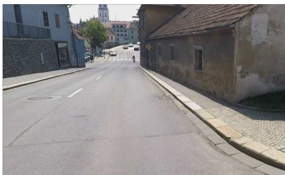
Obrázek 8.11: Příklad neadekvátních přístupových podmínek pro pěší s vysokým rizikem v ulici 9. května. Zdroj: Fotografie z aplikace CEBASS.
