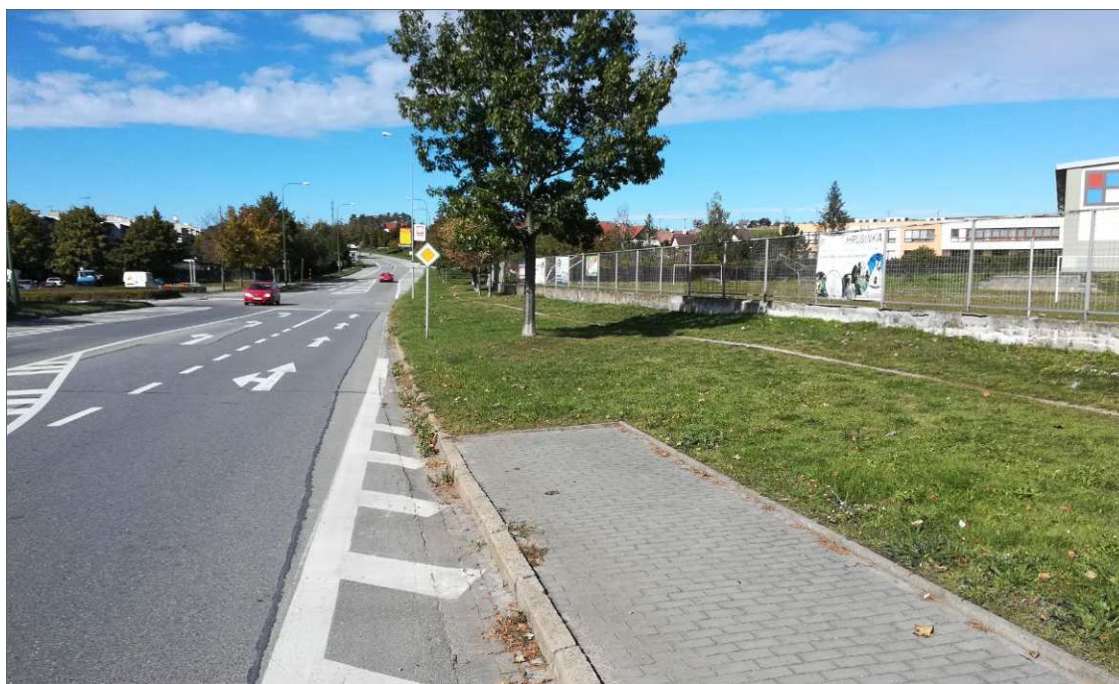
Obrázek 8.4: Absence chodníkové plochy v ulici Míčova.
